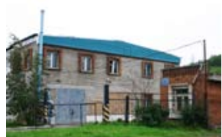
Цех благоустройства, он же — новый цех по переработке отходов металлургического производства
